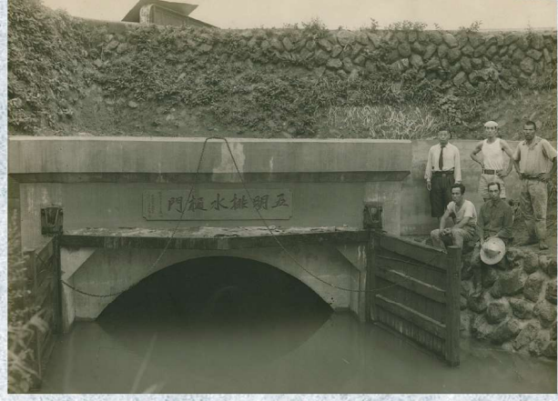
昭和24年 五明川排水樋門工事完成の様子(左上初代、左下2代目)
