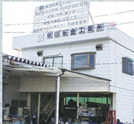
現在の社屋 南アルプス市前沢208-25
