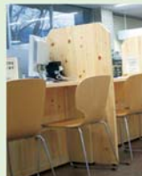
市役所本庁舎のカウンター工事
