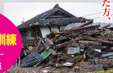
倒壊してしまった家屋
